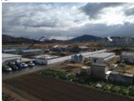
図-1 産業動物舎改築の様子
