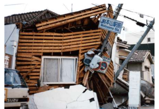
1995 年阪神淡路大震災における建物被害
