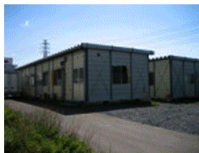
事務室・診療棟と入院棟
