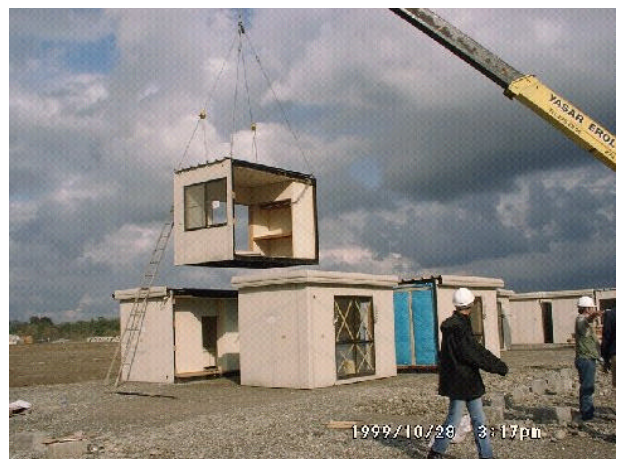
写真6 兵庫県の支援による仮設住宅の建設。尼崎市で使用されていた2戸1棟のタイプの仮設住宅を再利用している (アダパザル郊外)。
