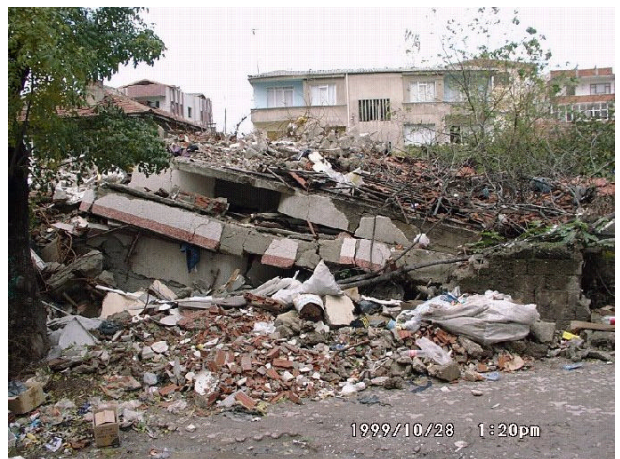
写真2 層崩壊を起こして倒壊した建物（アダパザル）。
