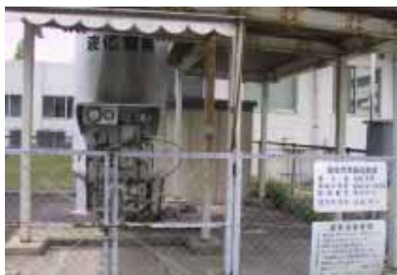
コールドコンバーターは液化ガスを貯蔵し、これからガスや液化ガスを取り出すための装置である。センターのコールドコンバーターは液化窒素専用の貯蔵・取り出し装置（最大貯蔵量は1トン）であり、岐阜大学内のすべてのユーザーは、この装置から、望むときはいつでも必要量の液体窒素を取り出すことができる。液体窒素は便利な冷媒であり、これを用いると $-196$  という低温を簡単に実現できる。したがって、液体窒素は物理学、化学、生化学、医学ならびに生物科学の広い分野の研究において不可欠な冷媒となっている。また、液体窒素は、冷媒としての用途
