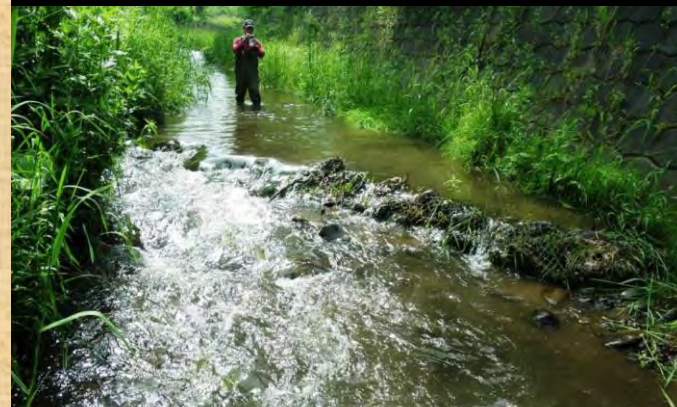
図6 バープ工 精進川放水路（北海道札幌市）
