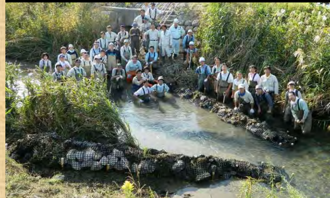
図7 ハの字バープ工 桂川（岐阜県揖斐川町）
