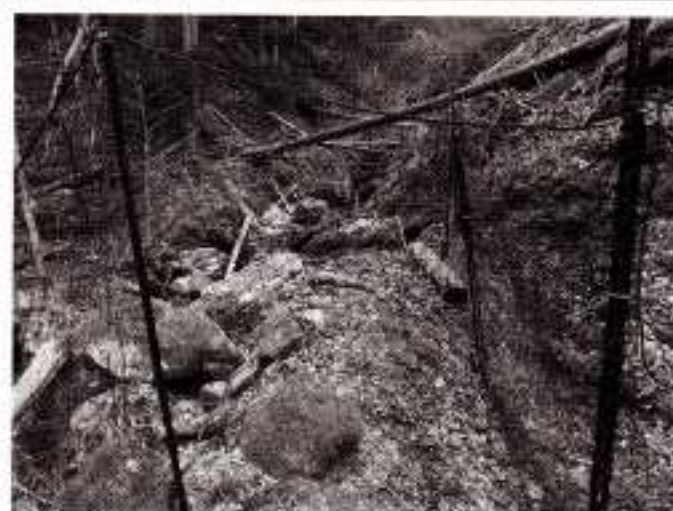
写真4 京都府南丹市芦生地区野生ワサビ保全地(X谷)におけるシカ柵設置風景(2016年3月31日完成)
