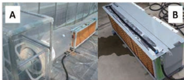
図 2 2種類の簡易設置型パッドアンドファン A) ダクト接続型、B) ファン一体型
