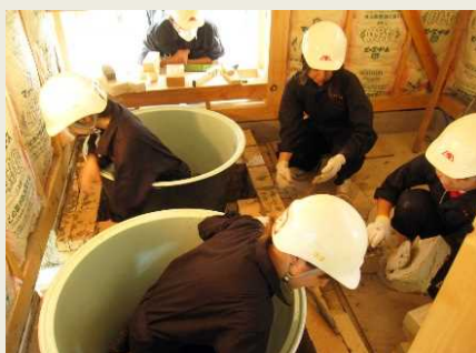
災害時浴室棟の建設工事の様子
