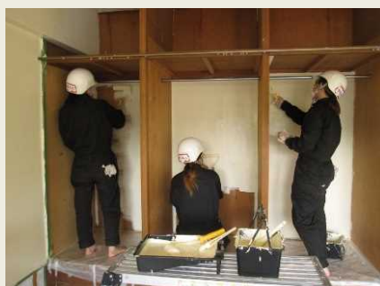
学生寮のリフォーム工事の様子
