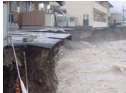
図 郡上市被害状況 (県検証委員会資料)
