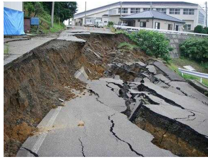
道路盛土の崩壊(左:滑落崖、右:のり面中段ならびにのり止工のはらみ出し)状況。
