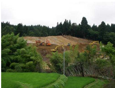
対岸より崩壊地を望む(排土作業)
