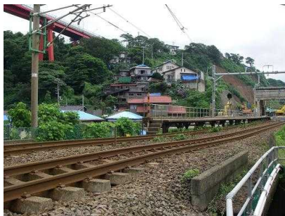
信越本線青海川駅部の盛土の沈下
