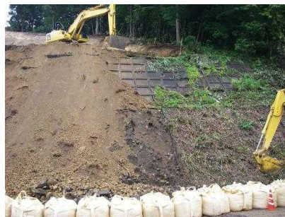
崩壊斜面脇 (栗石詰めめのり杵工)
