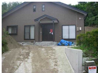
中越地震後に建設 (宅地 1m 嵩上げ)
