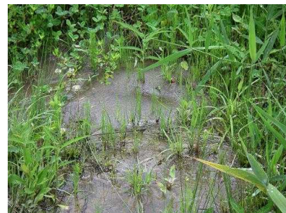
道路脇には噴砂現象を確認
