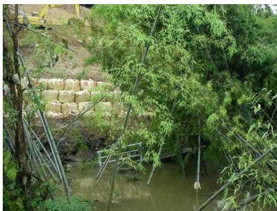
復旧工事 (盛土のり尻の応急復旧)
