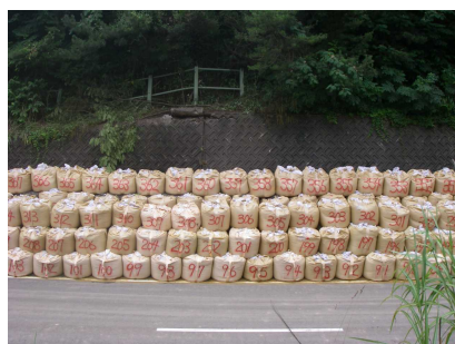
応急復旧の土嚢積工
