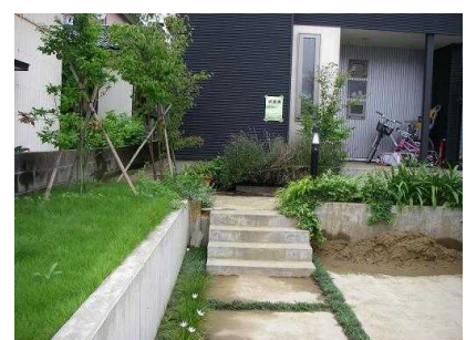
新築住宅周辺の噴砂（建物問題無し）
