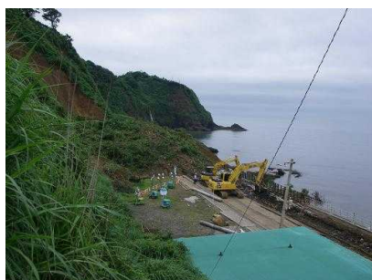
信越本線青海川駅の復旧工事
