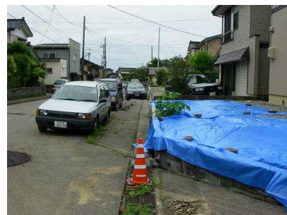
左住宅は堤内地側にズレている
