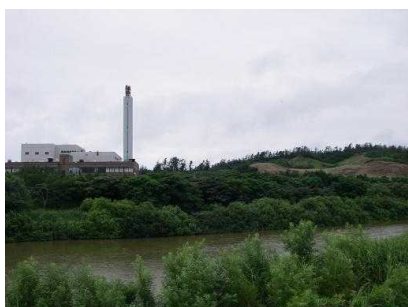
対岸の被災した処分場と砂丘
