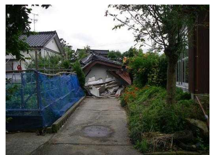
倒壊建物（旧河道の淵）
