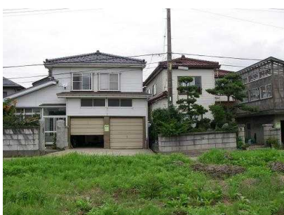
左の建物は僅かに右側へ傾く（旧河道淵）
