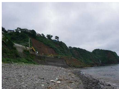
海水浴シーズン間近の青海川海岸から崩壊斜面（左：青海川駅、右：鴫ヶ鼻）を望む 谷根川右岸の崖崩壊（段丘層の崩落）
