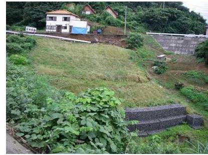
道路盛土の崩壊(左:滑落崖、右:のり面中段ならびにのり止工のはらみ出し)状況。
