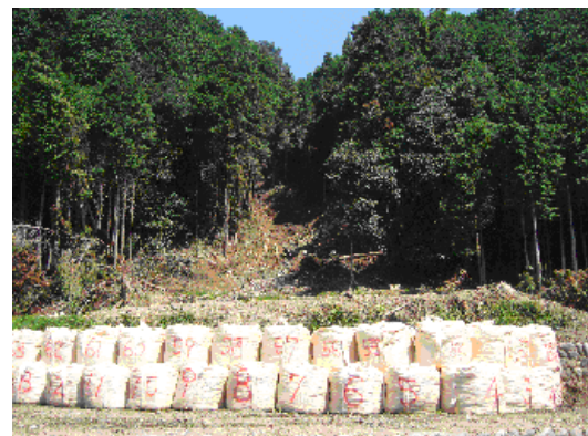
図8 大型土のうが設置された斜面下部の様子
