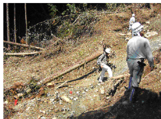
図9 崩壊部分の様子
