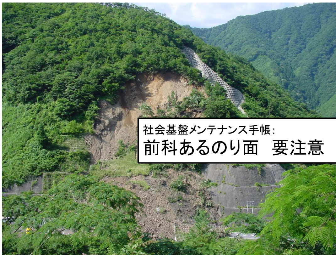
県管理国道 のり面崩壊(約5,000m 3 )
