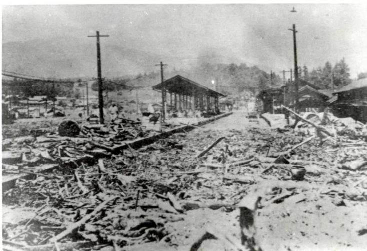
国鉄中津川駅は深さ約1間(1.8m)の土砂堆積
