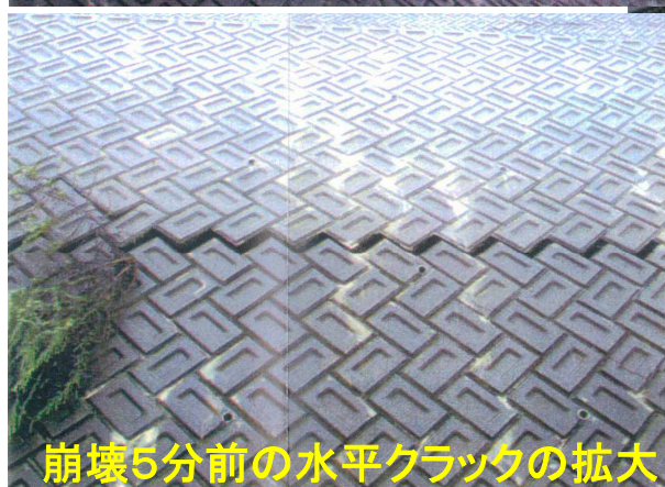
崩壊10分前の擁壁の変状
