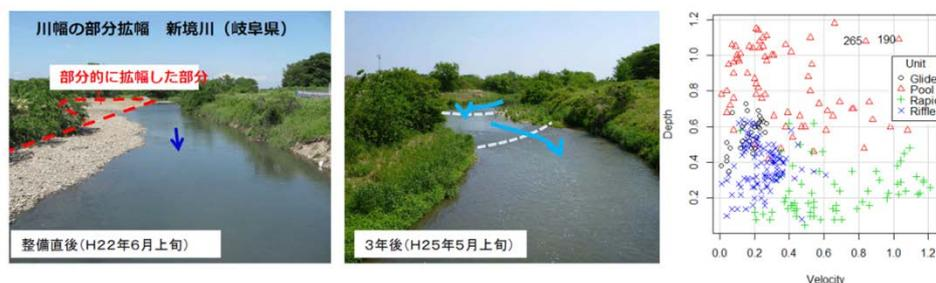
図 5 部分拡幅工法（新境川，各務原市）
