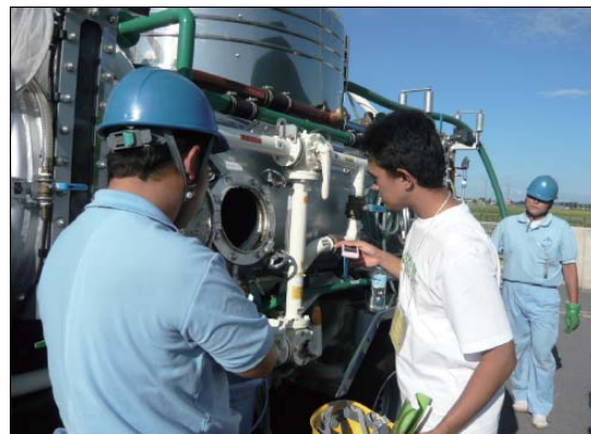
図5 岐阜県内浄化槽現場にて
