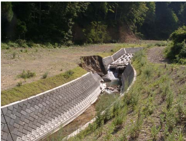
写真－1 神通川水系宮川支川畦畑川における河道被災の事例（2002年8月17日撮影）
