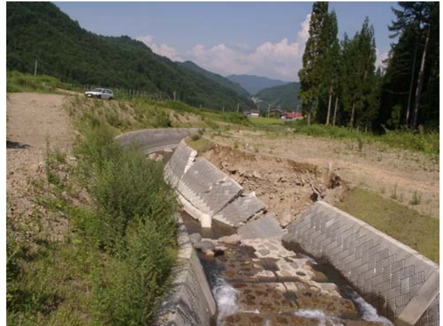
写真－1 神通川水系宮川支川畦畑川における河道被災の事例（2002年8月17日撮影）
