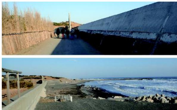
写真3 海岸堤防の例（茨城県鹿島灘神向寺地区、鹿島港の北側。2019年1月撮影）上：海岸堤防の陸側。海への眺望がなくなる高さに設定されている。嵩上げ工事により、海岸堤防の色合いが違っている。下：海側の様子。海岸堤防の前面には養浜が行われている。遠方にヘッドランドが見える
