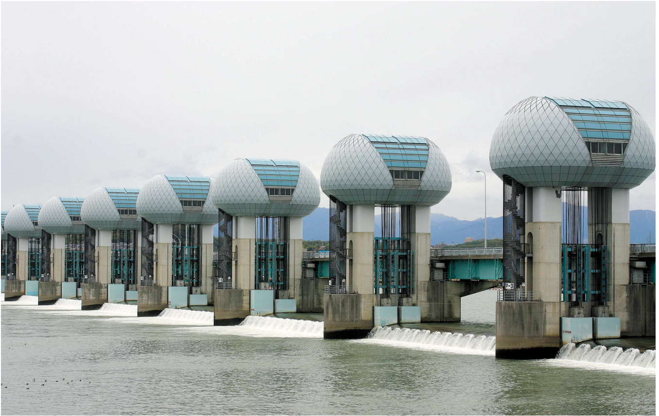
長良川河口堰 下流側より撮影 (写真1)
