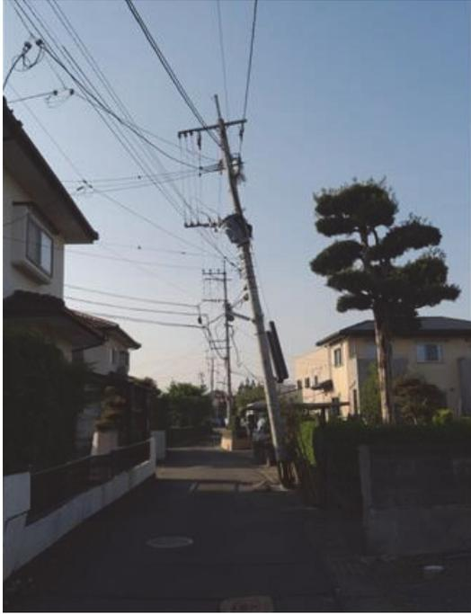
写真 2.1 電柱の傾斜（益城町）
