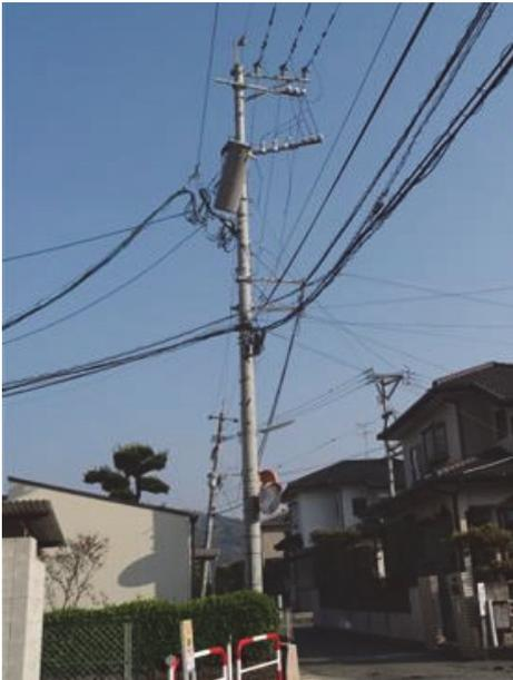
写真 2.3 柱上変圧器の破損（益城町）
