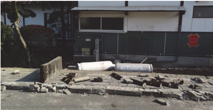
写真 4.2 LP ガスボンベとブロック塀の倒壊 (益城町)
