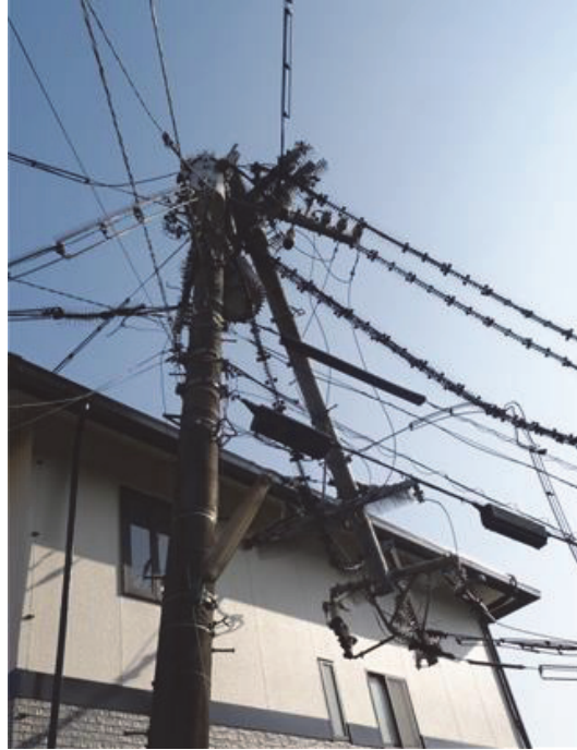
写真 2.2 電柱の折損（益城町）
