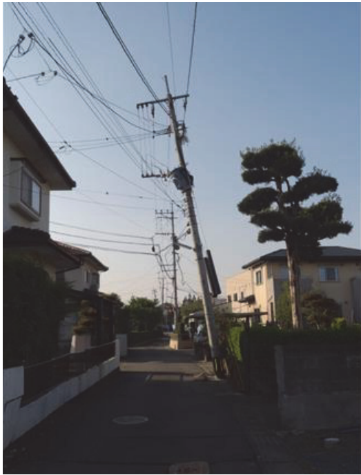
写真 2.1 電柱の傾斜（益城町）
