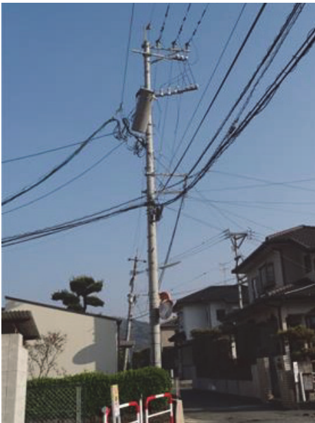
写真 2.3 柱上変圧器の破損（益城町）
