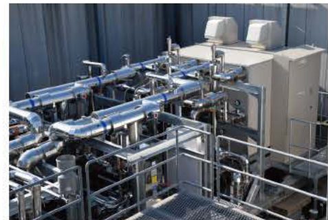
図3 地下水熱利用ヒートポンプ
