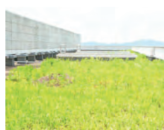
（写真 3）屋上緑化
