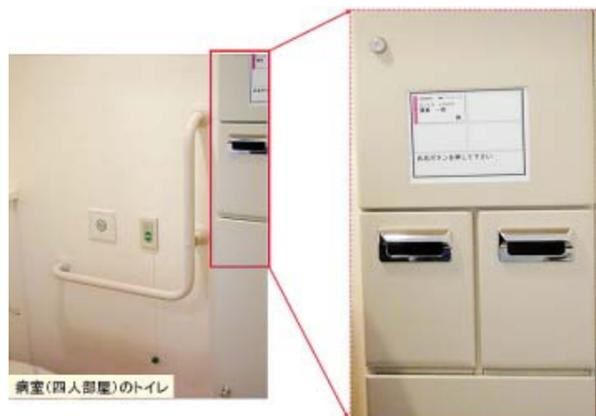
図 1.2-4 病室内トイレに設置された蓄尿計システム
