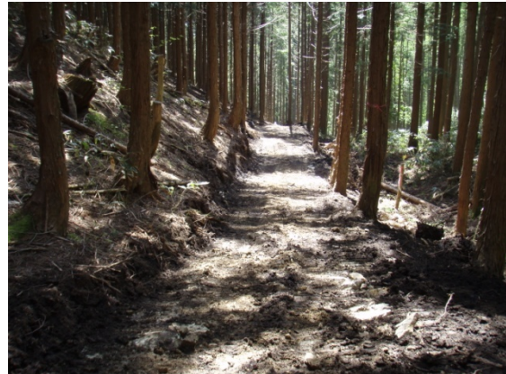
新設した作業道
