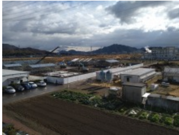
図-1 産業動物舎改築の様子
