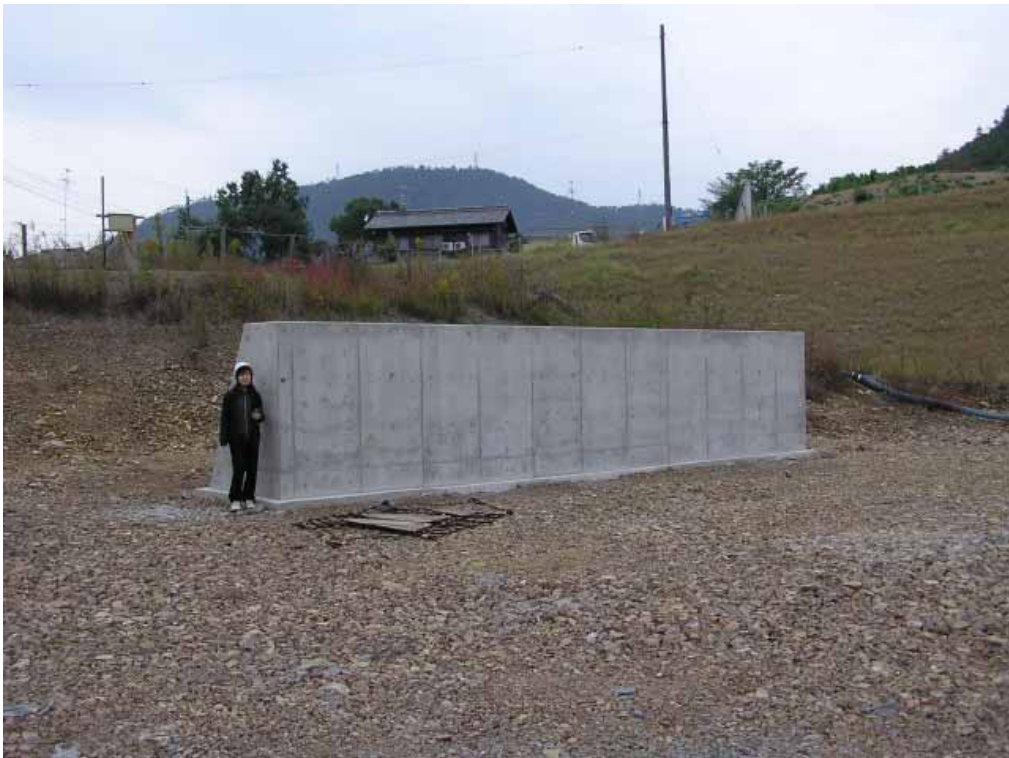
コンクリート擁壁外観
