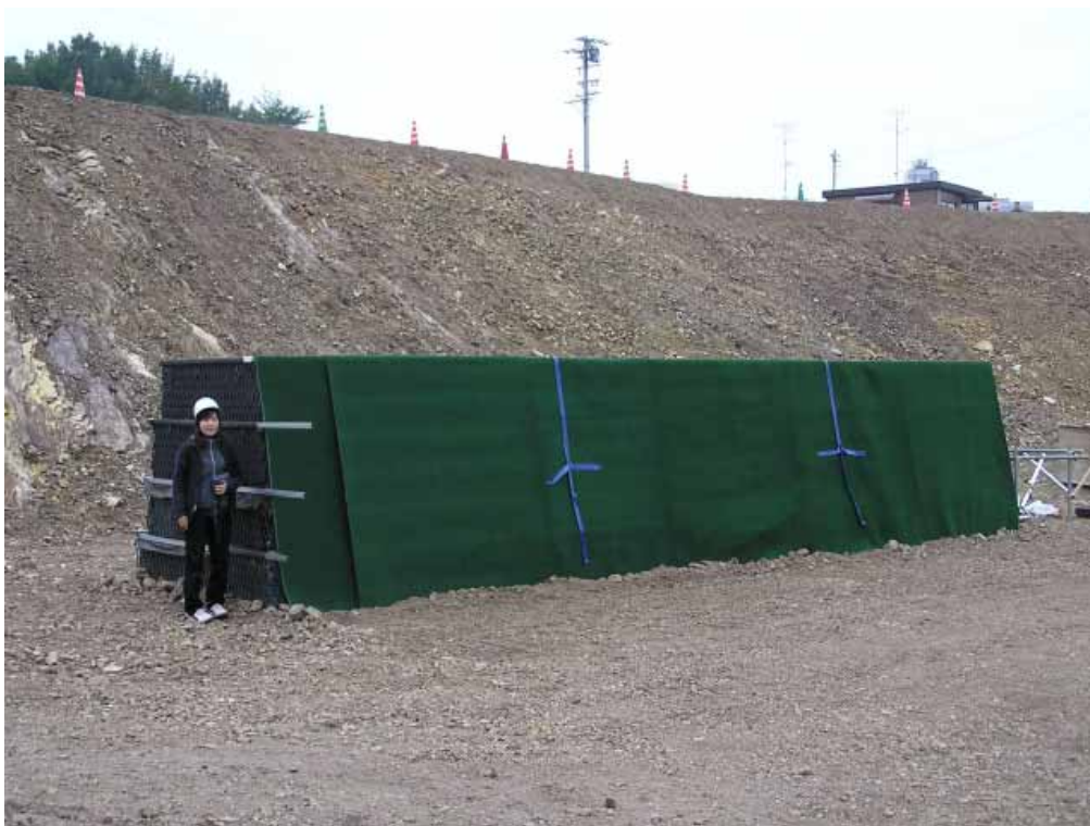
堤防型補強土防護壁外観
