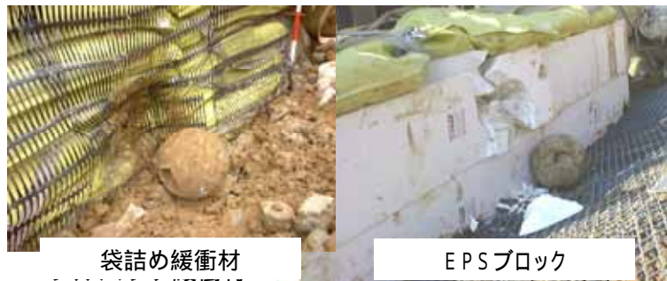
図 - 9 落石衝突後の緩衝材の変形状態
