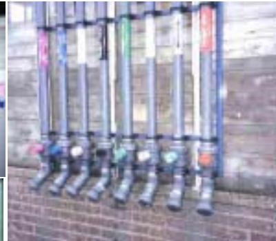
分析会社のプレート(左写真)。ハウス内に設置された養液の原液タンクと、施設外のタンクローリーからの供給口。
